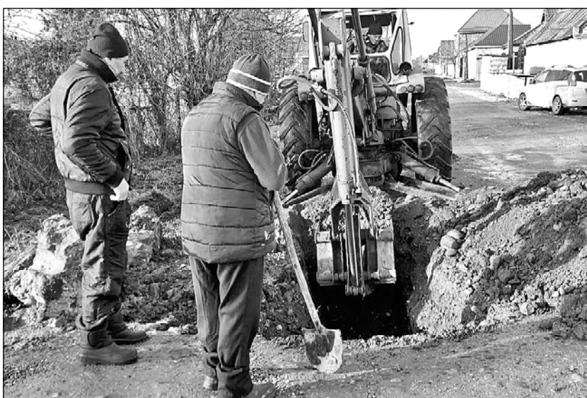
На снимке: устраняется прорыв на водопроводе по улице Шукова.
