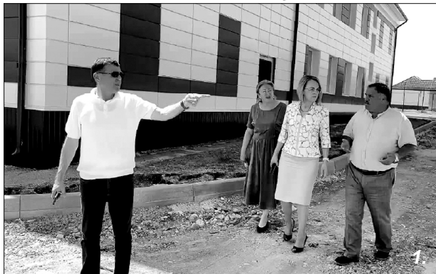
Фоторепортаж о том, как завершается реконструкция здания МОУ СОШ им. В.М. Кокова в с.п. Кишпек и создается школа завтрашнего дня, которая будет служить нескольким поколениям местных детей.
